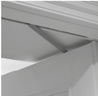
Вставленное устройство автоматического закрывания
